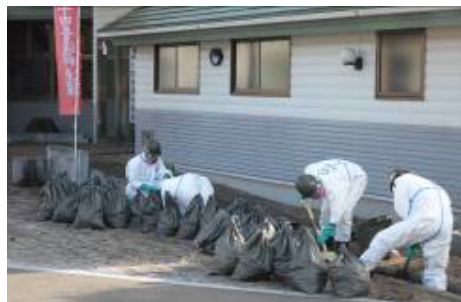
飯舘村役場における側溝の汚泥除去
